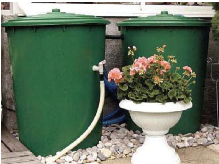
Figur 22. Tunna kopplad till stuprören
