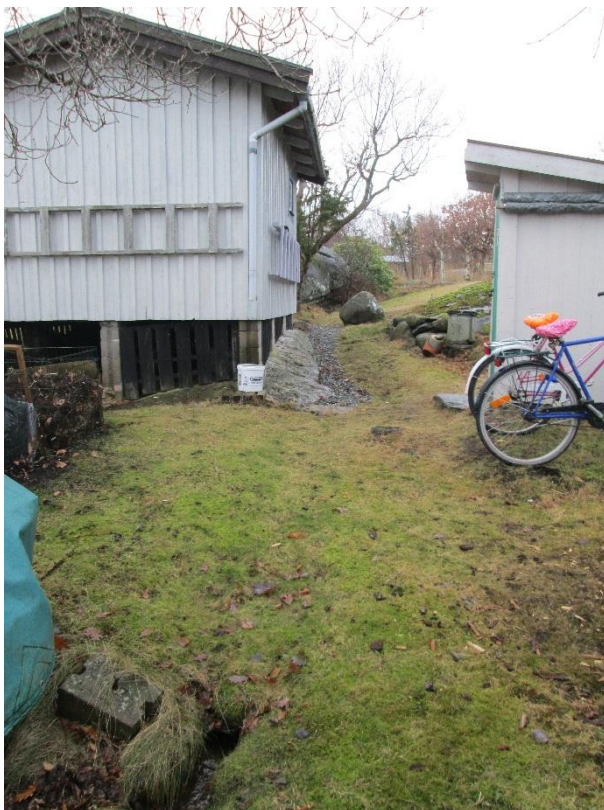
Figur 11. Visar dike/makadamdike som korsar privat fastighet.
